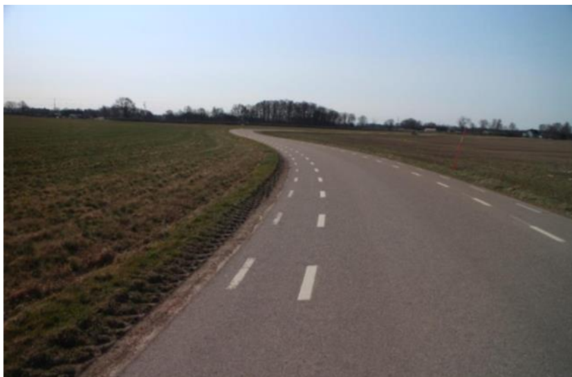
Figur 9 Gamla och nya vägrenar vid ett FoI-projekt med bygdevägar i Skåne. Trafikverket har senare fastslagit att de gamla vägmarkeringarna bör tas bort då endast en vägren bör finnas.
