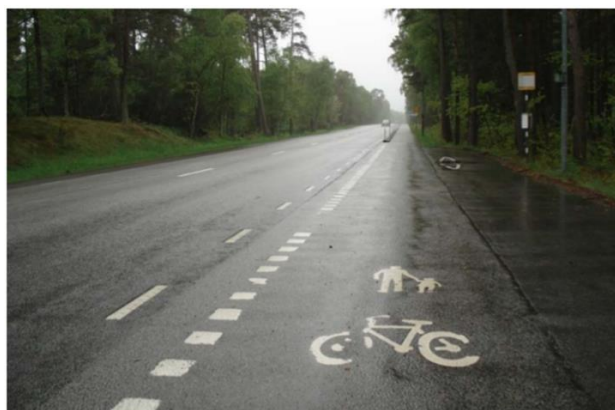
Figur 52 Väg 9 vid busshållplats mellan Ystad och Nybrostrand
