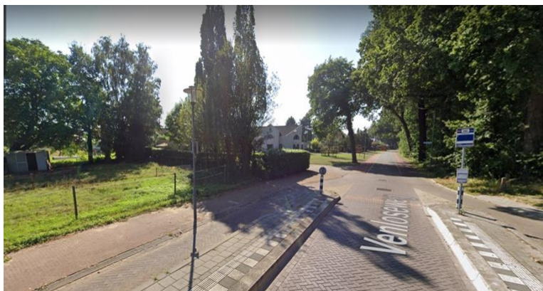
Figur 54 Utformning vid början av en nederländsk bygdeväg via en busshållplats
