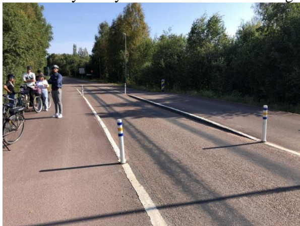
Figur 51 Hammarös lösning med flyttbara pollare
